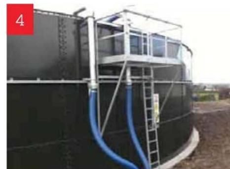
4 作業者のプラットフォーム及び梯子キットからジェッターキットまたは注入パイプを使用してスラリータンクに注入する
